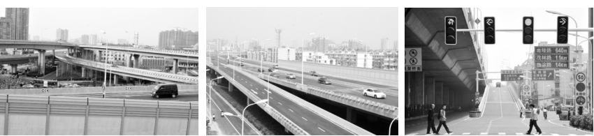
裕溪路高架桥建成通车
