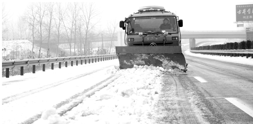
图为大型除雪机械正在合淮阜高速连续作业
