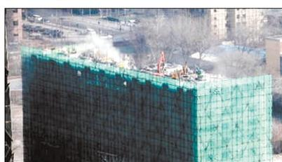
26日下午,北京朝阳区光华路清华大学继续教育学院东侧一待拆高楼上,出现几台正在作业的挖掘机,机器发出“轰隆隆”的响声,硕大的楼板被挖掘机“踢”下楼顶。记者在待拆高楼处看到,该楼共有10层,近30米高,楼体被绿色安全网围住,楼下堆满一些被拆掉的建筑垃圾。楼顶几台挖掘机正在作业,发出“轰隆隆”的响声,随着“砰”的一声闷响,只见两平方米大的一块楼板从10层楼顶坠落,噼里啪啦掉落在楼底的建筑垃圾堆上。记者致电朝阳区安全生产监督管理局执法大队,工作人员称,这种施工方式还没见过,是否安全不好说,他们将关注此事。 黄海蕾
