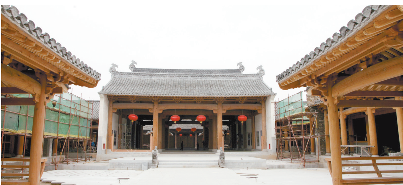
1月11日,歙县古城内即将修复完成的徽州府衙。
