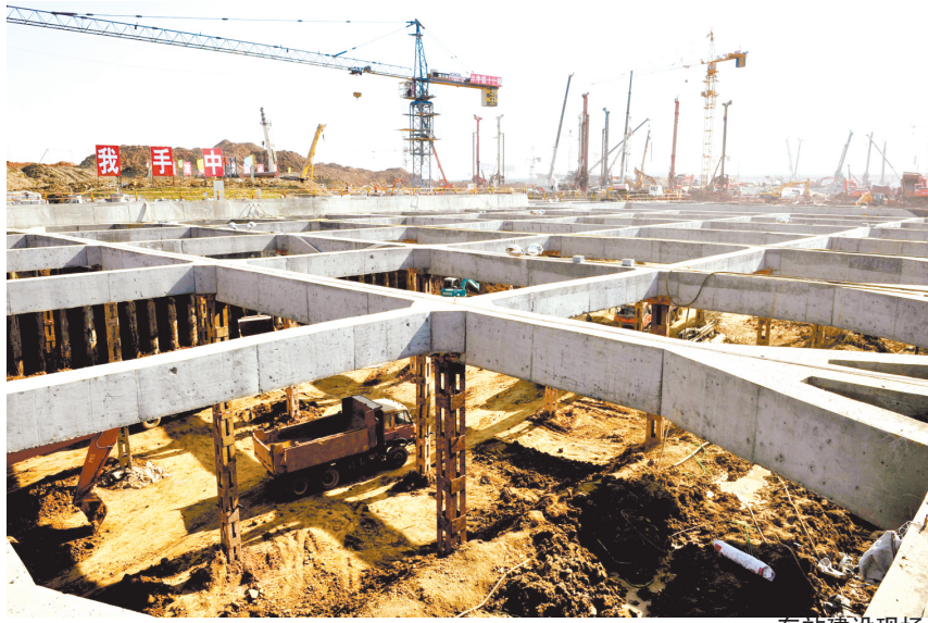
车站建设现场
