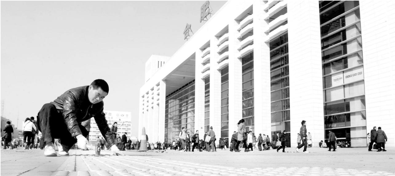
昨日,工人们正在合肥火车站前广场铺设崭新的盲道。据了解,自12月19日以来,合肥市瑶海区自筹资金20余万元对合肥市火车站前广场的无障碍设施进行增设,内容主要为盲道贯通、无障碍停车位以及对广场破损地面进行修复等。贯通后的盲道整体长约400米,连接了火车站售票处、出站口和进站口,并新增设无障碍停车位2个,为出行的旅客带来方便,以崭新的面貌迎接即将到来的春运和新年。
