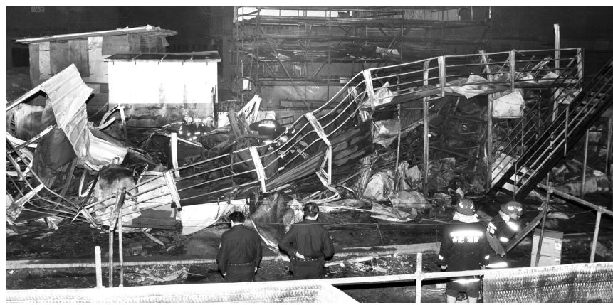
工地板房失火现场
