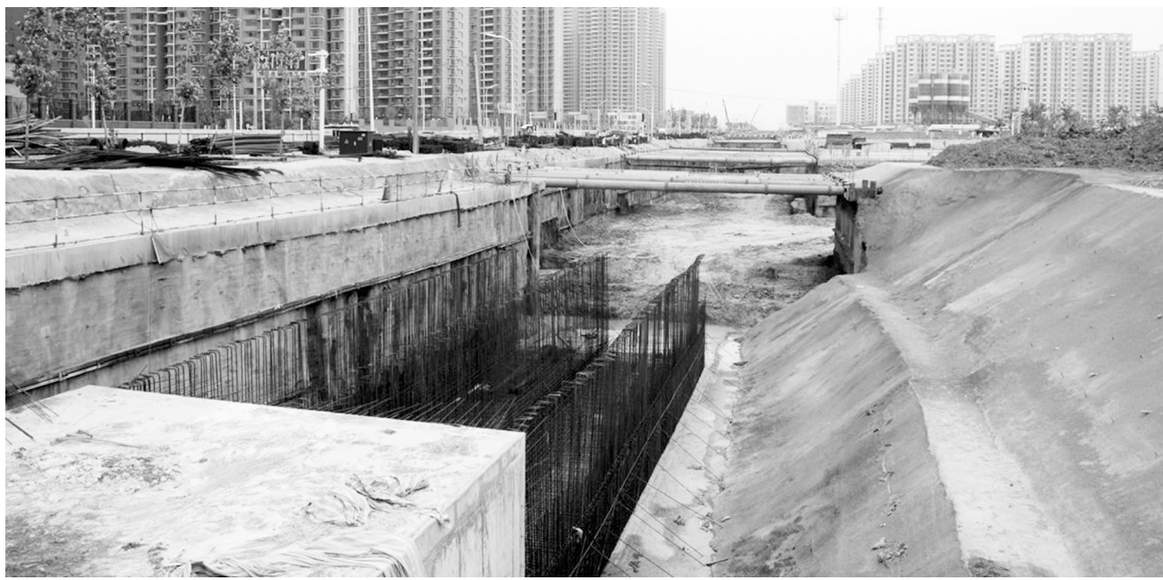
合肥轨道试验段回填前图片
