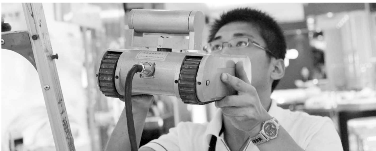
工作人员准备将“机器人”送进空调通风管
