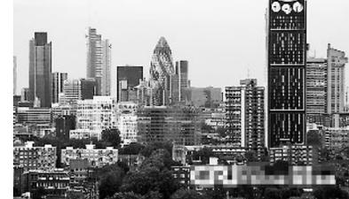
位于伦敦城市天际线的斯特拉塔,是首座融入“风轮机”的摩天楼——大楼上的三座风车将为大楼提供8%的能量,独特设计让它获得了“电动剃须刀”的外号。但这座高达146米的伦敦最高住宅楼被贴上了“纯视觉污染”的标签,也被提名为2010年英国最丑陋的建筑。 综合
