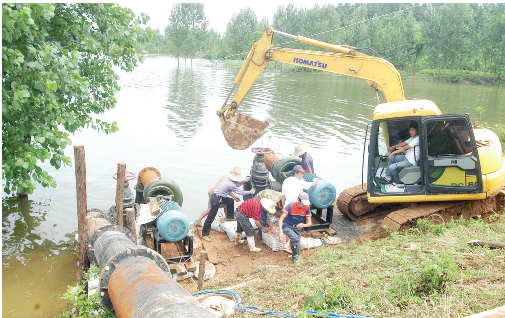
7月17日上午,在铜陵市郊区铜山镇显化圩堤坝上,刚刚从省防汛抗旱物资储备库调运来的水泵,正在加紧安装。在省有关部门的帮助下,5台功率55千瓦水泵紧急调运到显化圩、双丰圩进行排涝,帮助农民尽快进行补栽补种。 过仕宁 文 图
