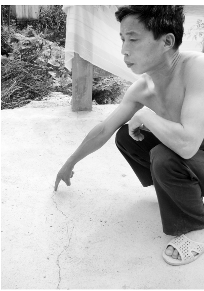
桥面的裂缝
