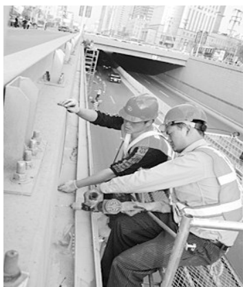
“畅通一环”亳州路下穿桥施工资料图片
